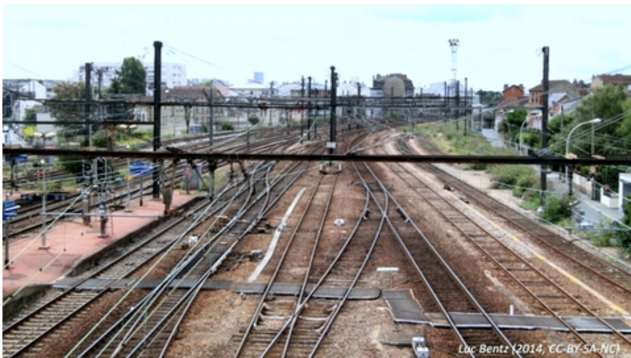
Vue de la gare de Juvisy en 2014 (photo Luc Bentz, CC-BY-SA-NC)
